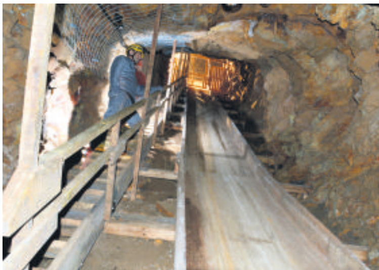
Stopnice in drča vpadnika, ki povezuje vstopni in glavni rov.
